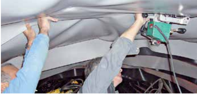
Trabajando con la COMET en un túnel ...
