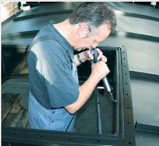
DIODE S en aplicación en la soldadura de extrusión en el diseño del depósito.
