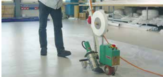
Soldadura de bandas a máxima velocidad.
