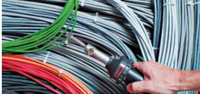
Instalación de una unión por retracción con el HOT JET S con reflector de tamiz acoplado.
