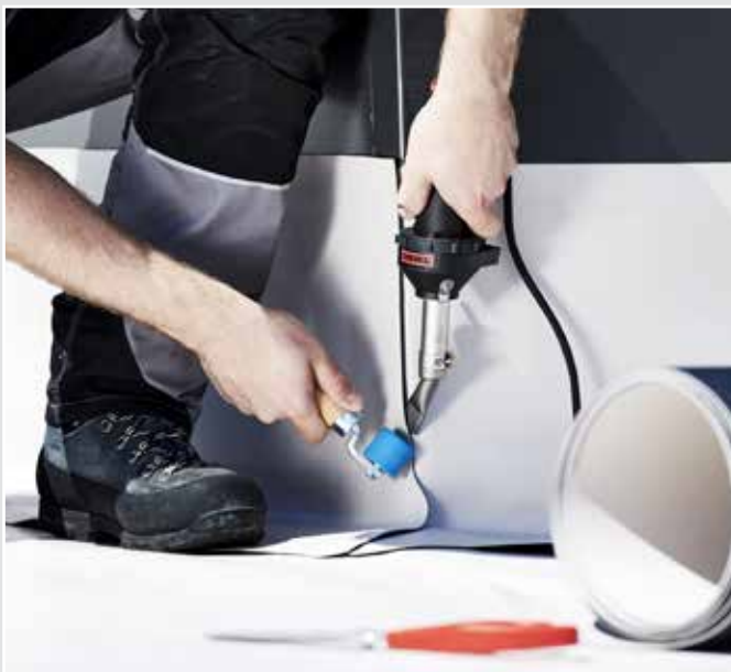
HOT JET S ideal para los trabajos de precisión en el techo.
