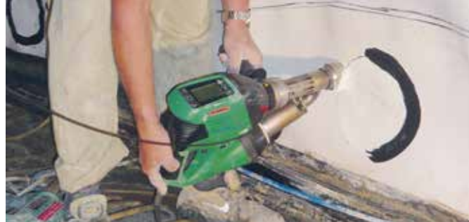
La robusta WELDPLAST S2 en soldadura de un „parche“ en la construcción de túneles.
