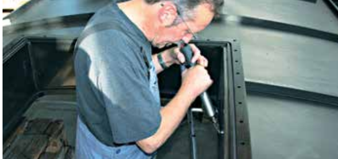
DIODE PID en soldadura por empuje en un contenedor de PE.
