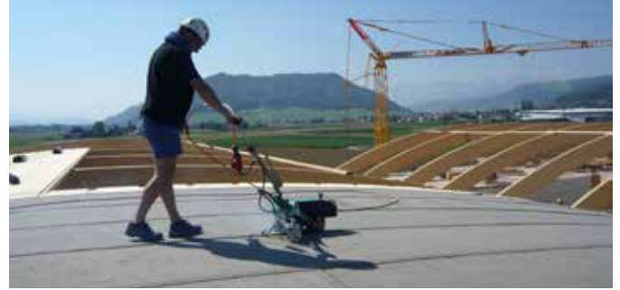
Fácil guiado del aparato y trabajo limpio con la BITUMAT B2.
